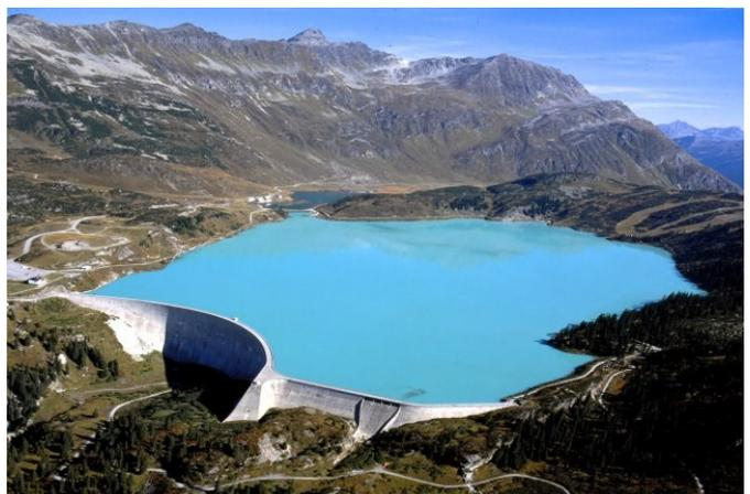
Pumpspeicherkraftwerke funktionieren wie Wasserspeicherkraftwerke. Zudem kann überschüssige elektrische Leistung aus dem Stromnetz gespeichert werden. Dazu wird Wasser aus niedriger Lage mit Pumpen in den höher gelegenen Speichersee gepumpt.
